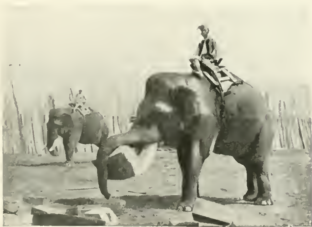
ÉLÉPHANT AU TRAVAIL DANS UN CHANTIER DE BOIS DE TEUK
